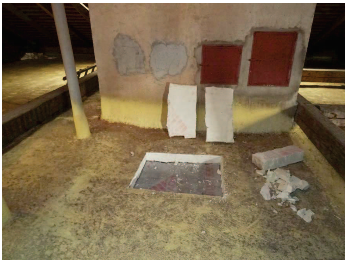
8. Sonda S3 do polyuretanové tepelné izolace
