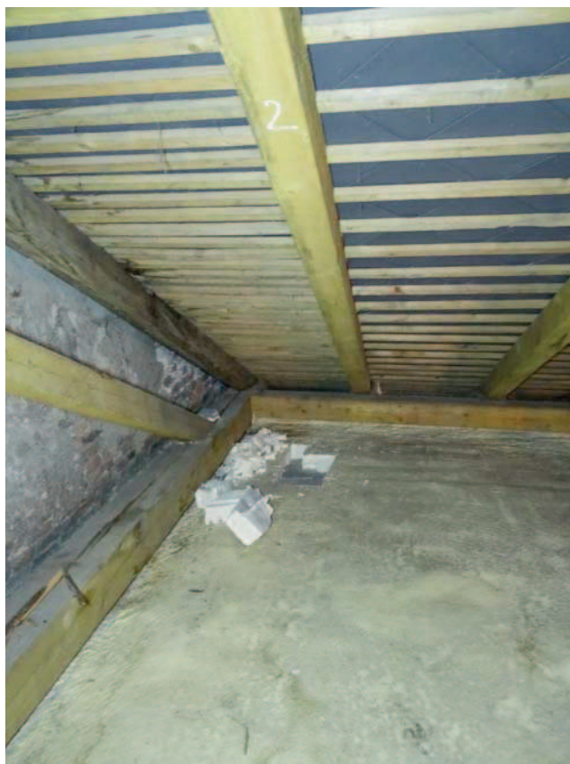
7. Sonda S1 do polyuretanové tepelné izolace
