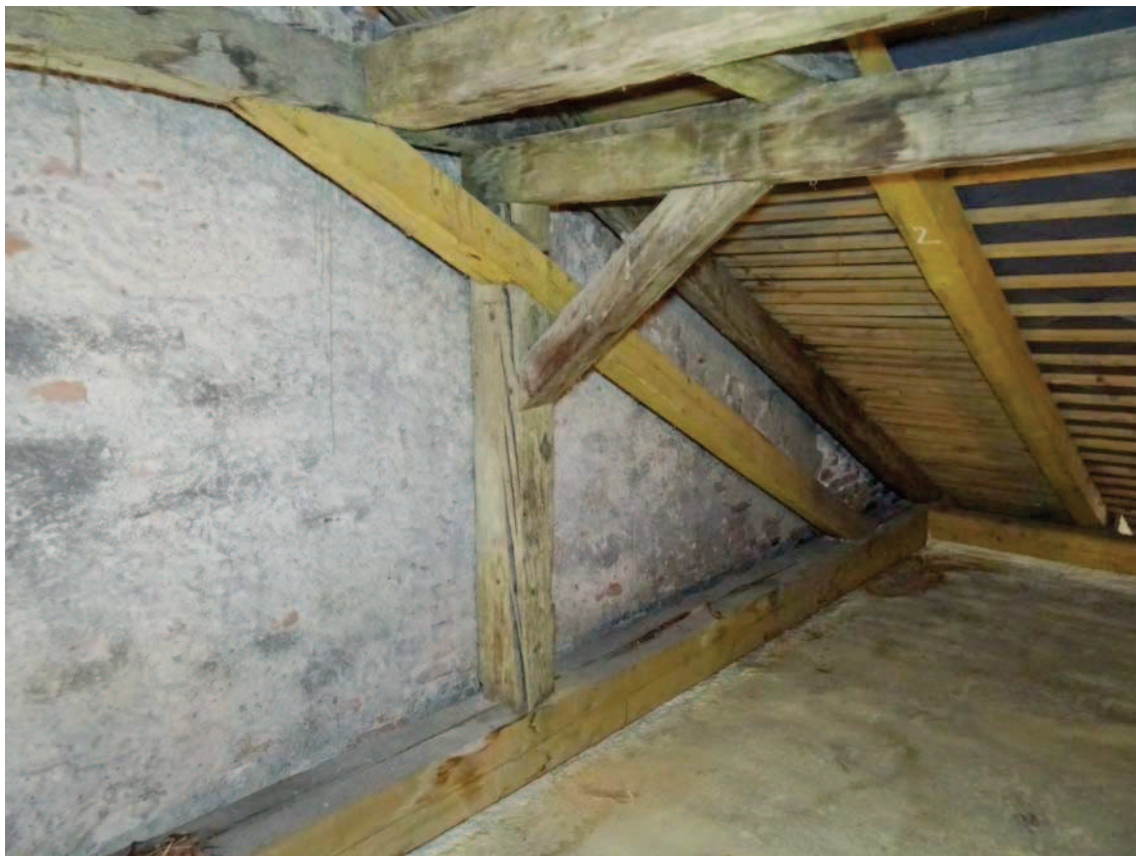
13. Zatékáním narušená plná vazba 1P (západní štít)
