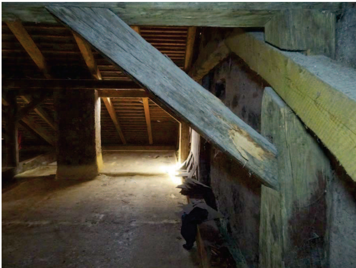
15. Dřevokazným hmyzem narušený pásek ve vazbě 1P
