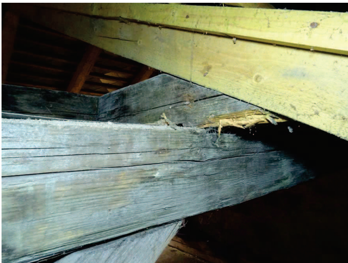
16. Dřevokazným hmyzem narušený hambálek (krátký) ve vazbě 4
